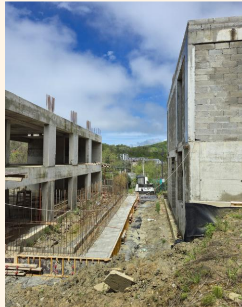
Подпорная стена по границе участка
