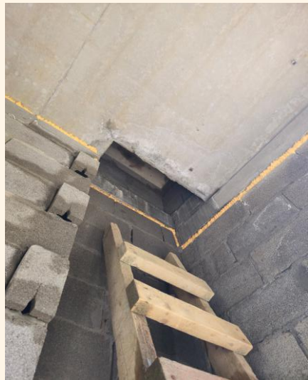
Вентиляционные шахты
