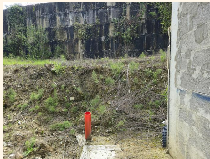
Дренаж по периметру фундаментной плиты
