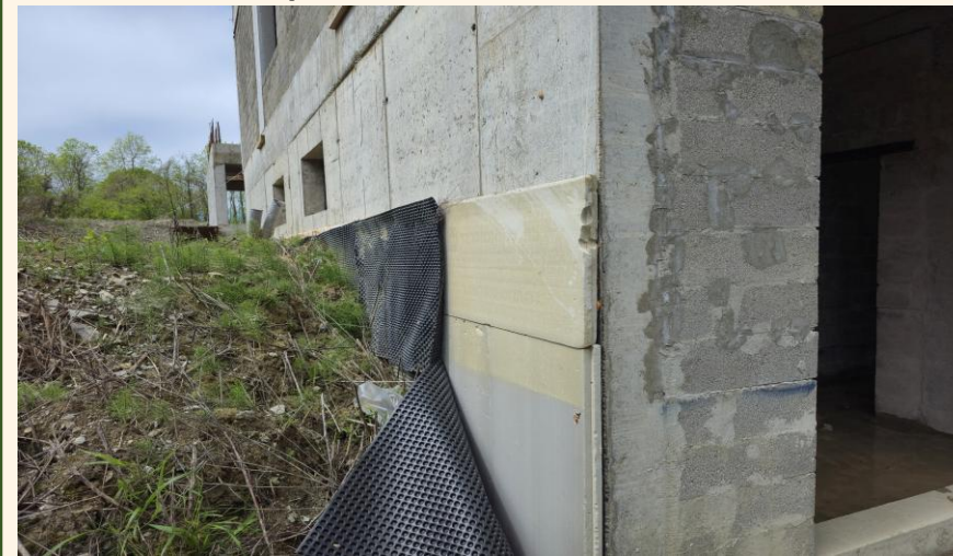
Утепление заглубленных стен дома
